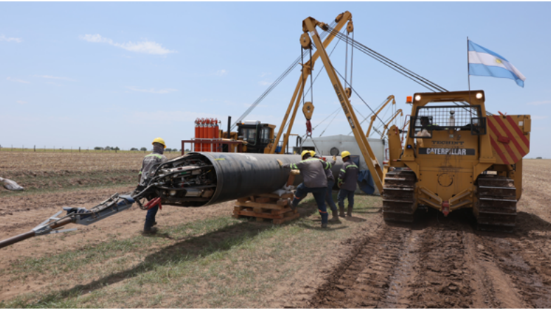
Gasoducto Perito Francisco Pascasio Moreno.
