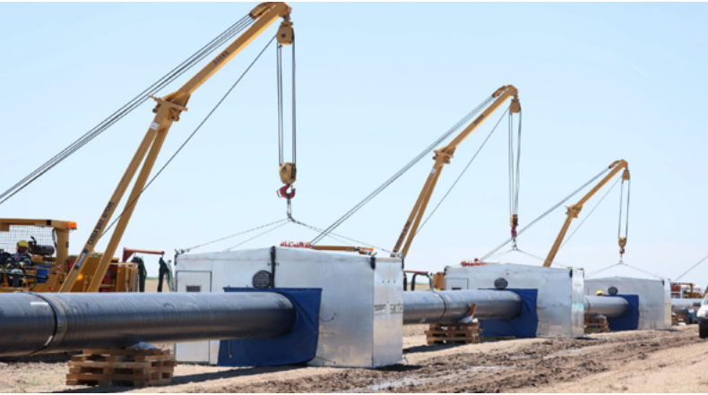
Gasoducto Perito Francisco Pascasio Moreno.
