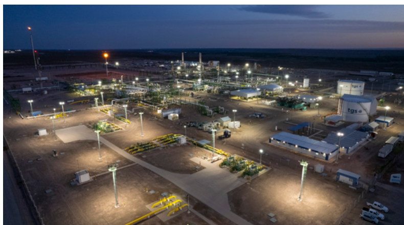
Planta Compresora Tratayén.
